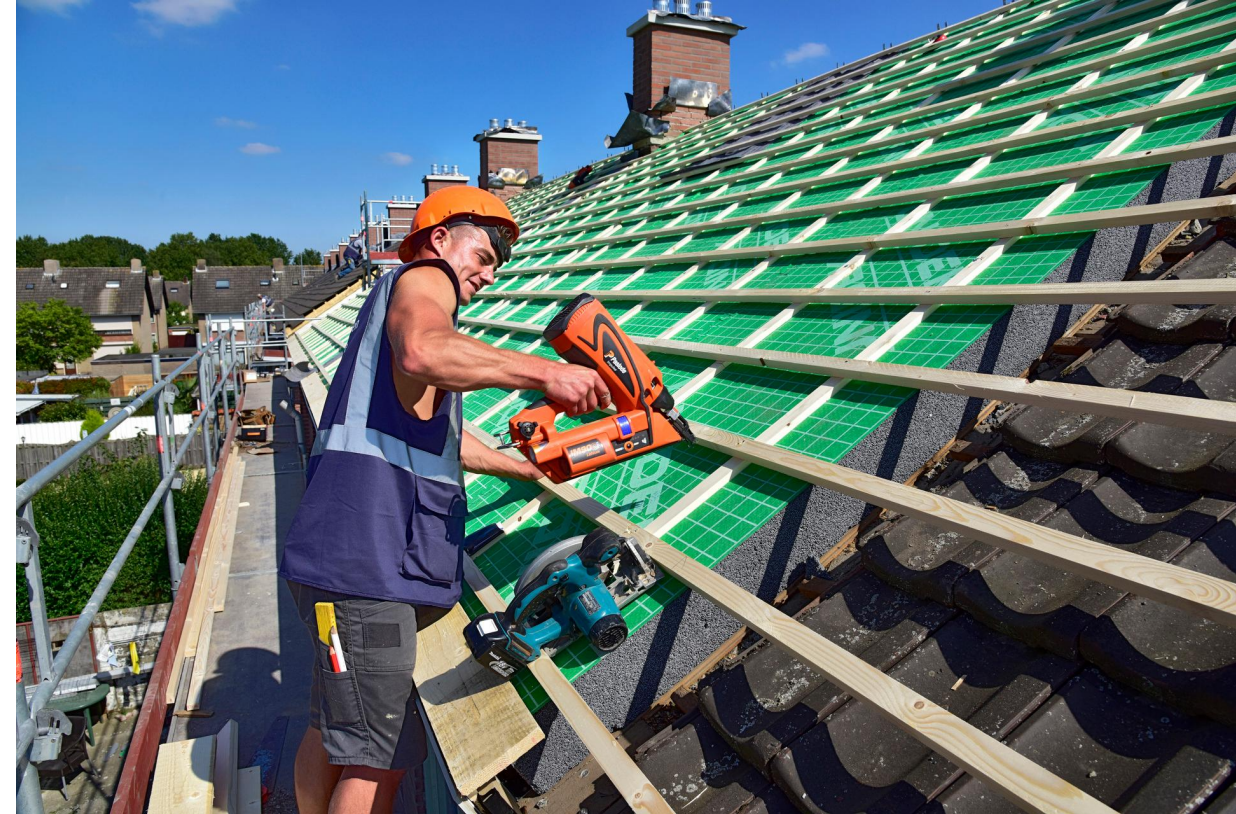
Renovatie dakisolatie huurwoning Raamsdonksveer. Foto: Riesjard Schropp
