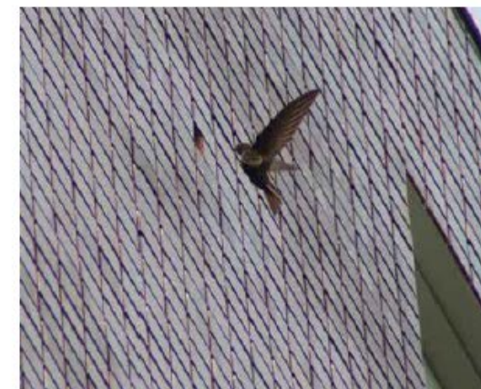
Gierzwaluwsteen weggewerkt in gevel
