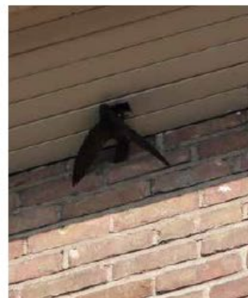
Gierzwaluwsteen weggewerkt in dakrand
