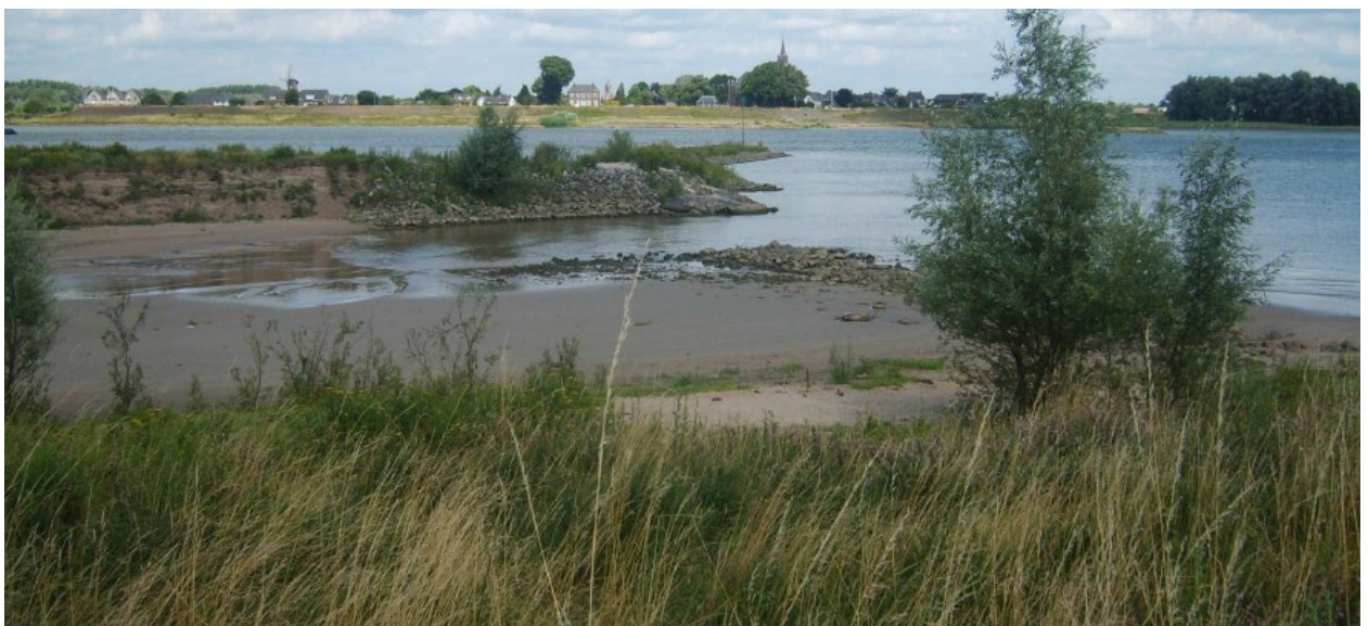
Figuur 1.22 Instroomopening Oostgeul Gameren. De geul verzand tot de hoogte van de drempel in de instroomopening (Foto Arjan Sieben)
