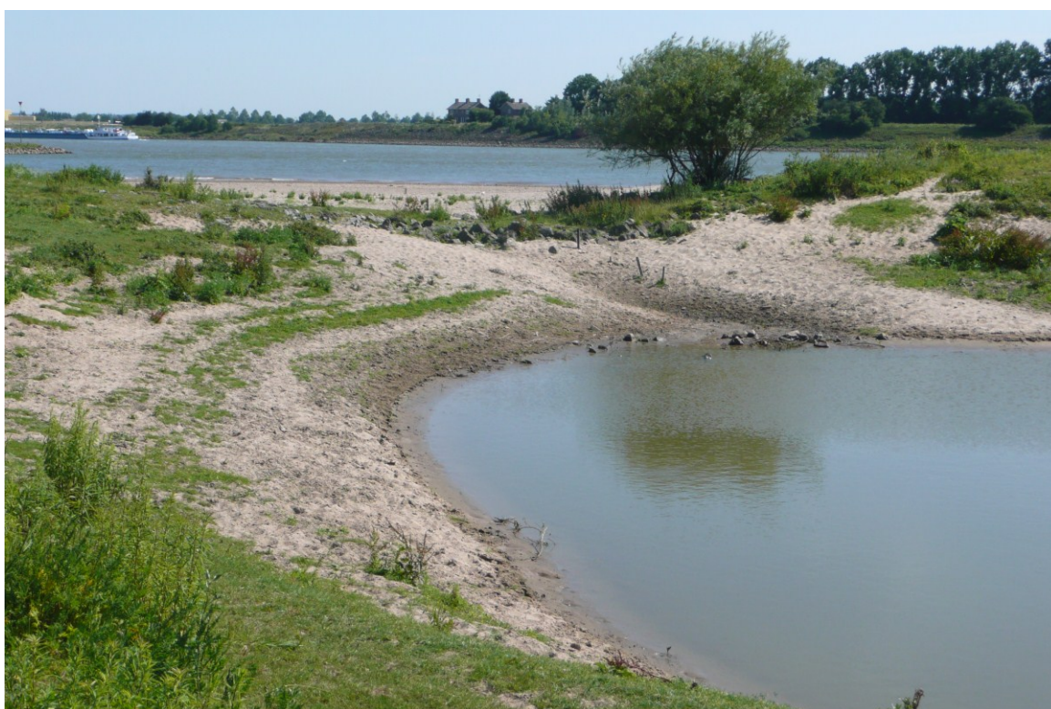
Figuur 2.11 Instromopening Klompenwaard (vanaf geulzijde gezien). De instroomopening van de Klompenwaard is een verlaging in de zandige uiterwaard. Na aanleg bleek deze zich tijdens hoogwaters te verplaatsen doordat de oeverwal aan de rivierzijde enigszins door erosie werd aangetast, daarom is de instroomopening later in stortsteen gelegd.
