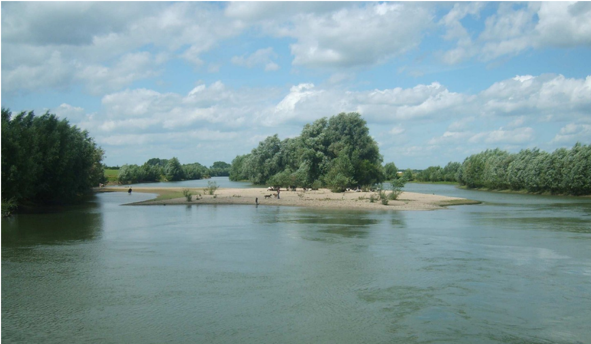
Figuur 2.5 Nevengeul Gameren, eilandvorming achter regelwerk, het sediment komt voor een groot deel uit een erosiegat net achter het regelwerk (foto Arjan Sieben, 15 juli 2009).
