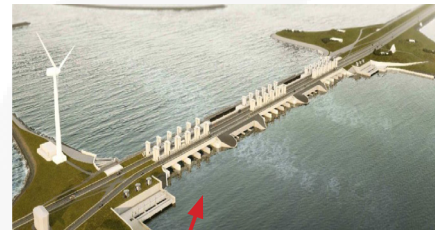
Sluizen / pompen Afsluitdijk
